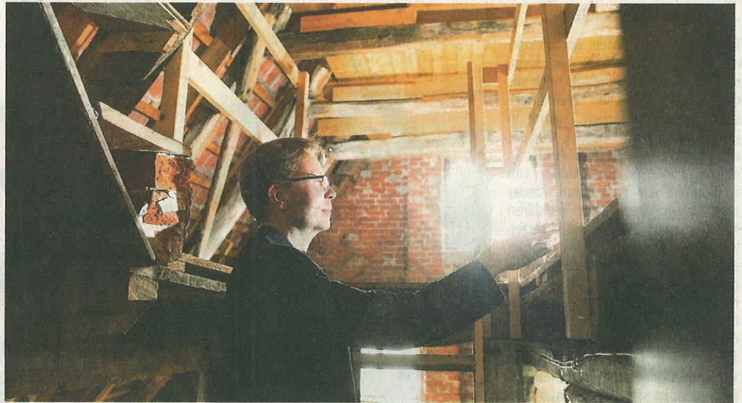
HAUS MIT GESCHICHTE: Architekt Gunnar Schulze inspiziert die Bausubstanz des historischen Münzhauses. Das ist vor über 700 Jahren errichtet worden und wird nun aufwändig saniert.
