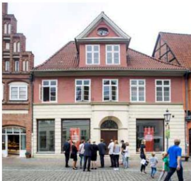
So sieht das Gebäude An der Münze 3 heute aus. Foto: t&w
