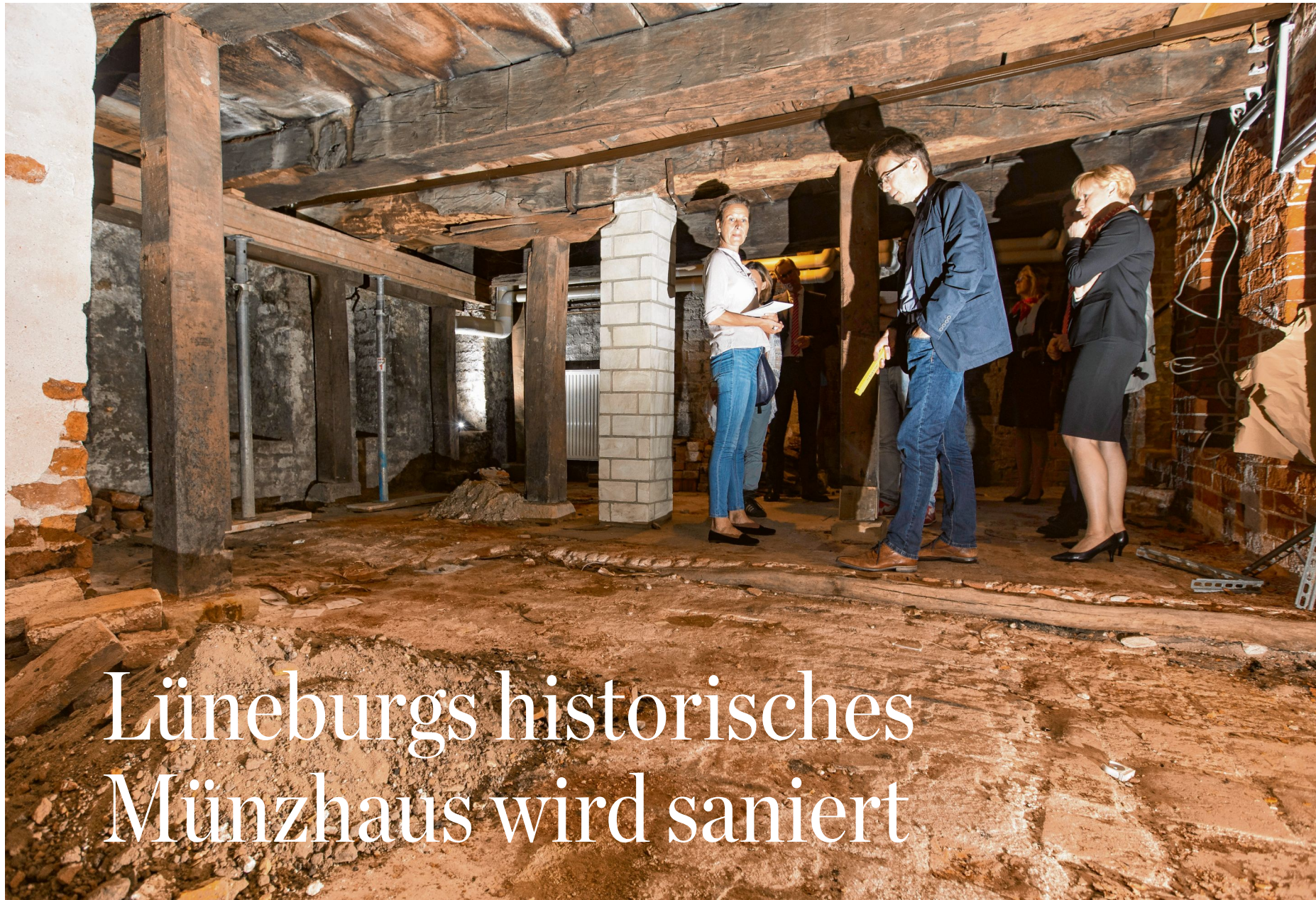
Architekt Gunnar Schulze macht sich beim Rundgang durch das Lüneburger Münzhaus ein Bild vom Zustand des Gewölbekellers
