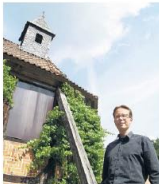
Bisher verhindern Stützbalken, dass die im Jahre 1580 errichtete Gutskapelle einstürzt
