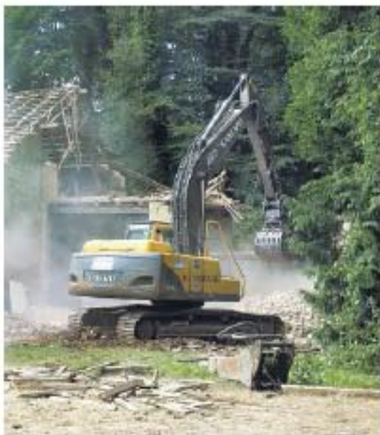
In der vergangenen Woche haben zunächst die Abrissarbeiten der Nebengebäude begonnen
