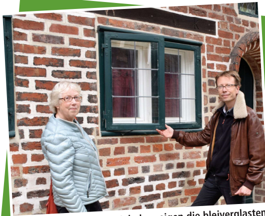
Elke Frost und Gunnar Schulze zeigen die bleiverglasten Fenster. Innen ist moderne Isolierung angebracht.
