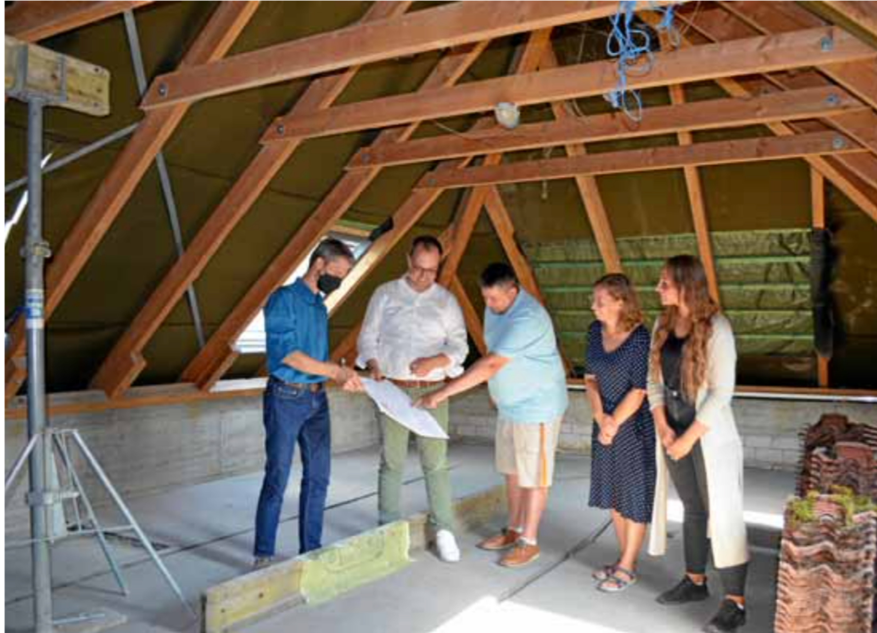
Besprechung unterm Dach (v.l.): Architekt Holger Heckwolf, Samtgemeindebürgermeister Steffen Gärtner, Michael Rösler und Maren Busse von der Verwaltung sowie die stellvertretende Kita-Leiterin Marie Bürger schauen sich auf der Baustelle um. Foto: uk
